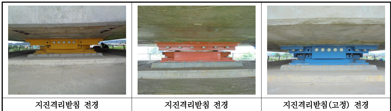
【사진 37.3.12】 교량받침 전경
