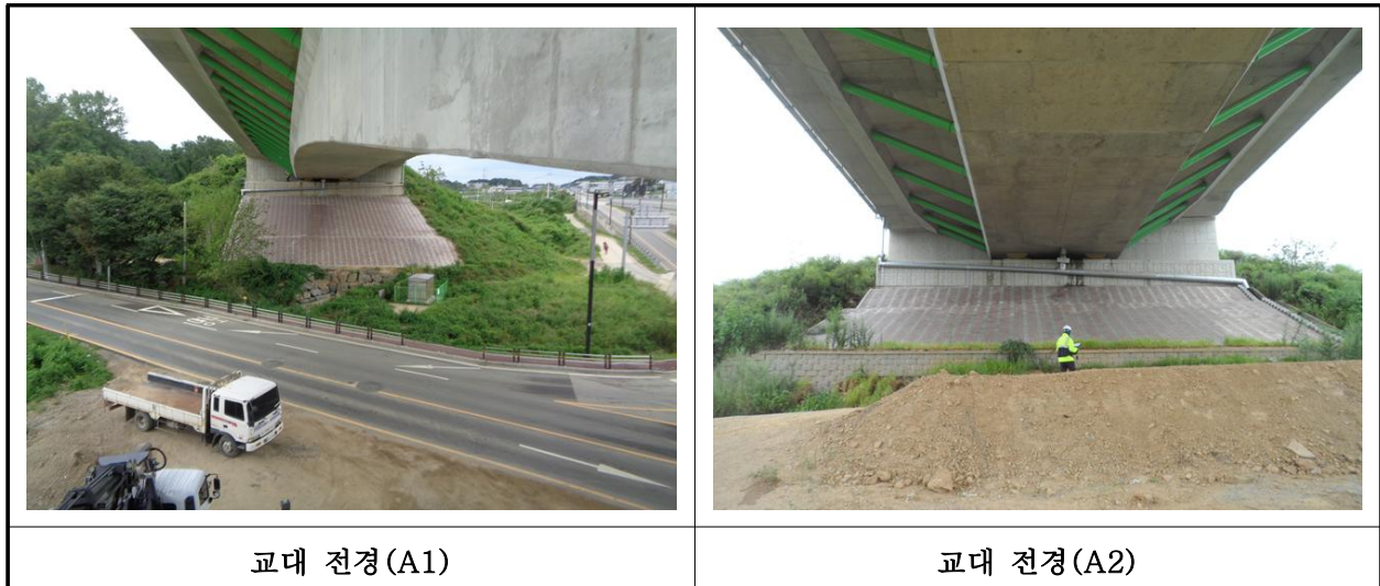
【사진 37.3.8】 교대 전경
