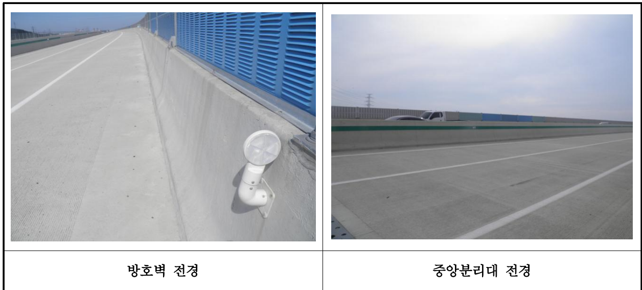
【사진 37.3.23】 방호벽 및 중앙분리대 전경
