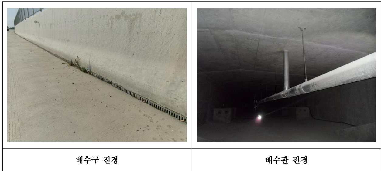
【사진 37.3.21】 배수시설 전경
