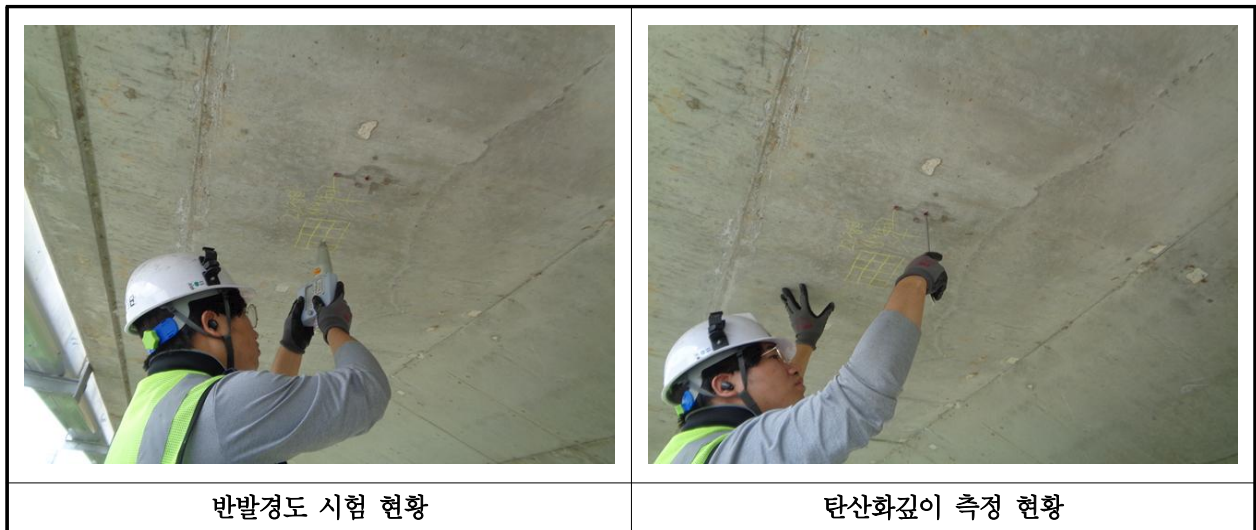
【사진 37.4.1】 콘크리트 내구성조사 현황
