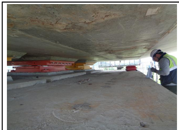
받침장치 연단거리 측정
