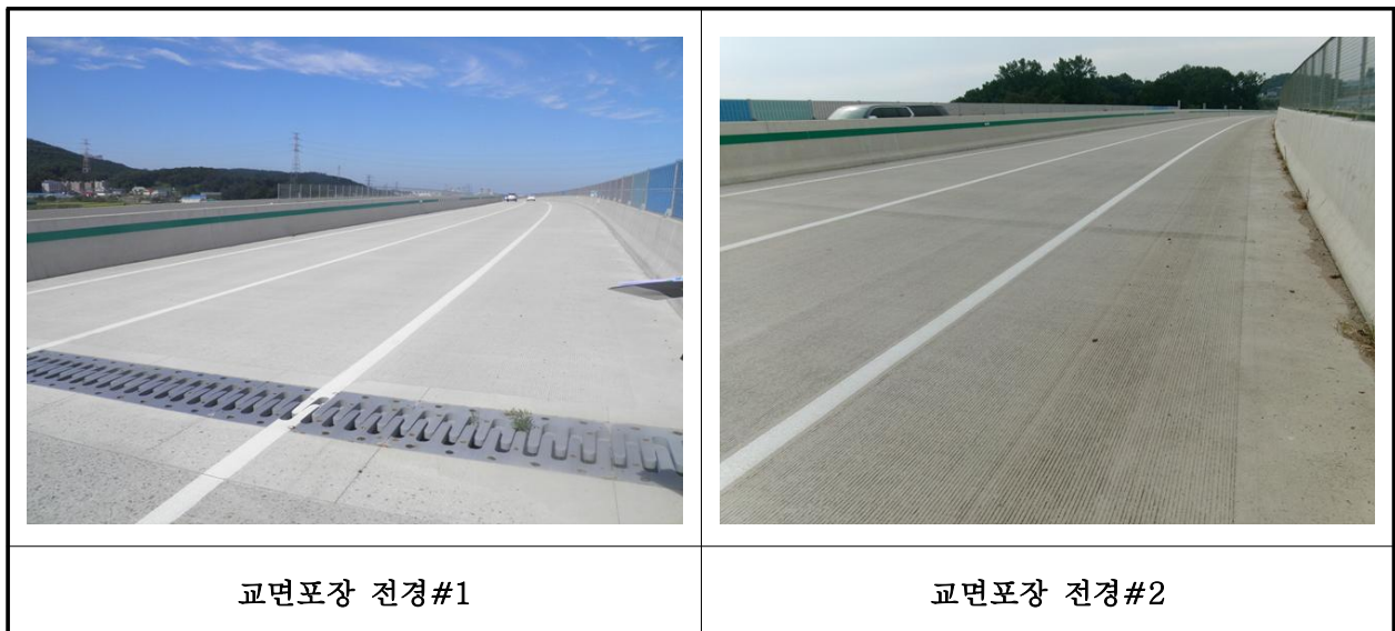
【사진 37.3.19】 교면포장 전경
