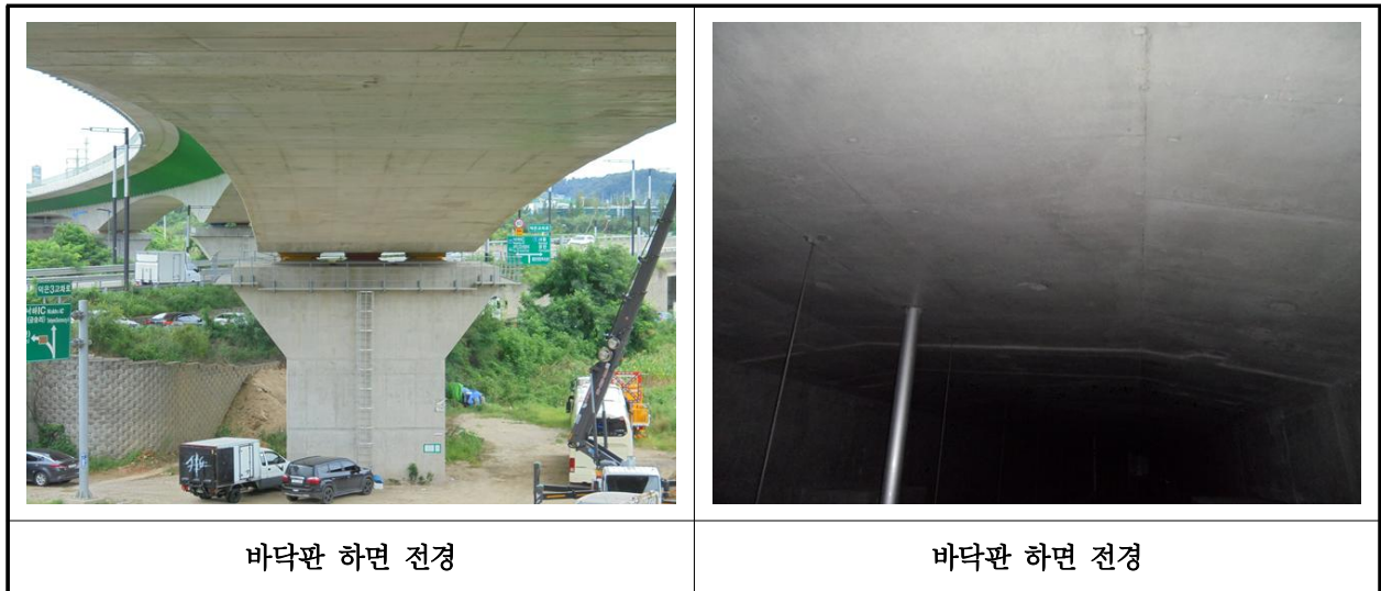
【사진 37.3.2】 바닥판하면 전경
